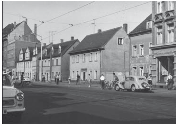
Der Zustand 1966, etwa 30 Jahre nach dem beschriebenen Umbau, südlich der Einmündung Coppistraße
