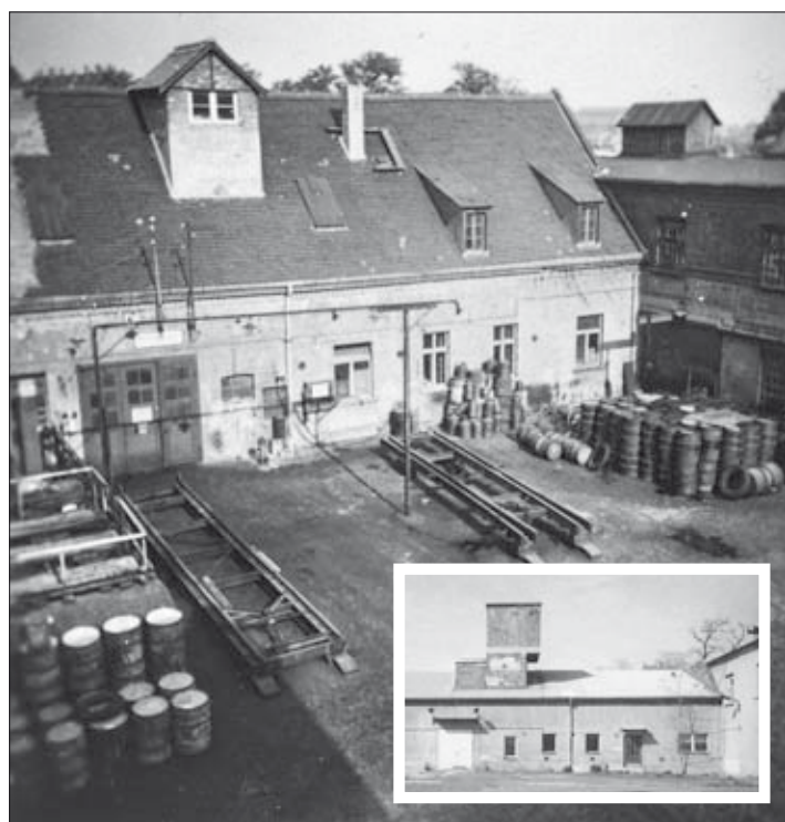
Gelände VEB Schmierstoffe, Görlitzer Straße 21 (früher Brauerei Eutritzsch), Mitte der 1950er Jahre; von links: Tanklager, Hauptgebäude mit Aufzug, davor die Gleise für Kesselwagen, die mit Culemeyer-Straßenrollern gebracht wurden; rechts die Fetthalle
