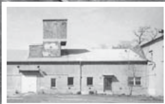
Gelände VEB Schmierstoffe, Görlitzer Straße 21 (früher Brauerei Eutritzsch), Mitte der 1950er Jahre; von links: Tanklager, Hauptgebäude mit Aufzug, davor die Gleise für Kesselwagen, die mit Culemeyer-Straßenrollern gebracht wurden; rechts die Fetthalle
