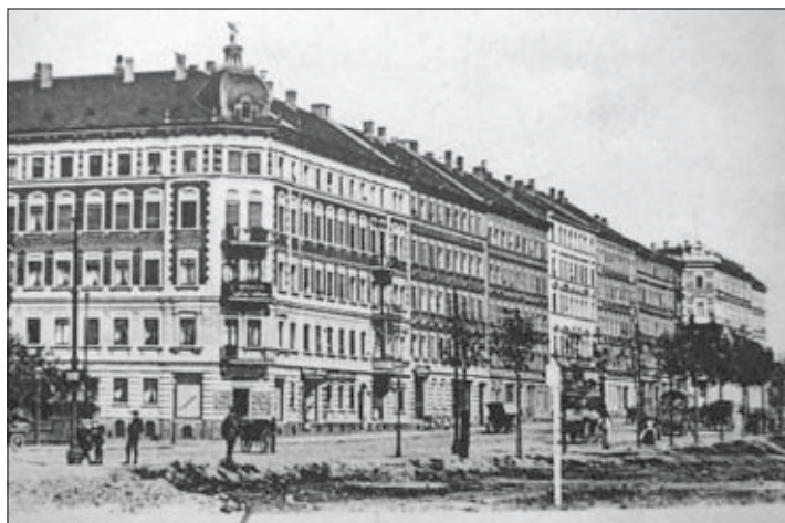
Blick vom „Eutritzscher Freiladebahnhof“ zur Delitzscher Straße, um 1900
