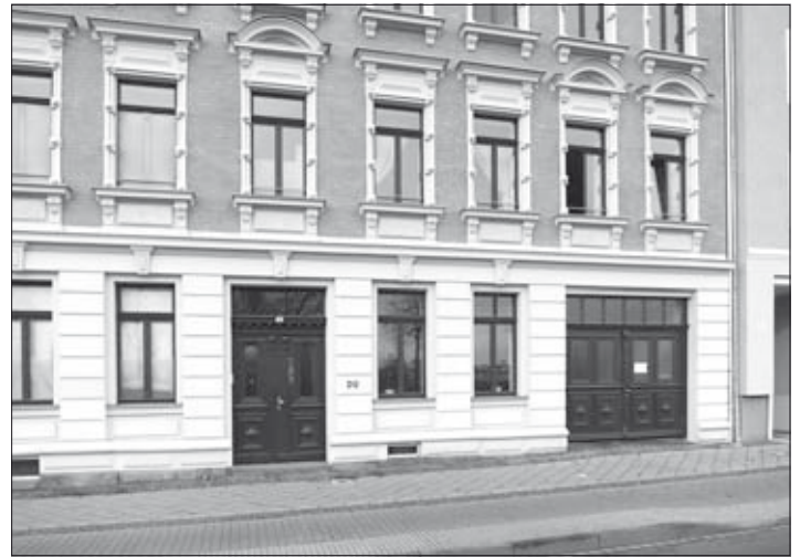
Die Front der Delitzscher Straße 7a nach der Sanierung, 12. November 2017
