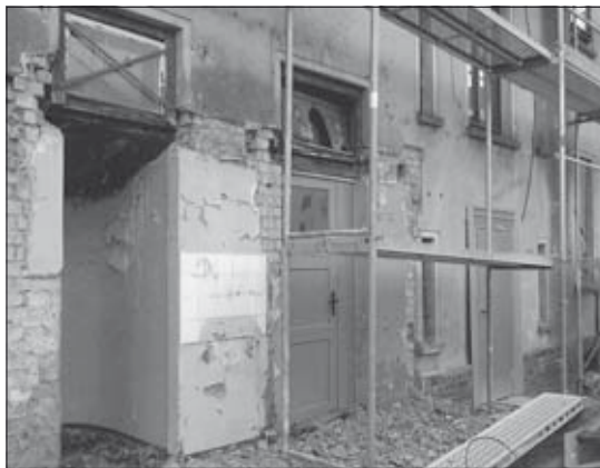
Die Gaststätte „Zum Freiladebahnhof“, Hofseite am 15. Januar 1998, Abbruch der Anbauten
