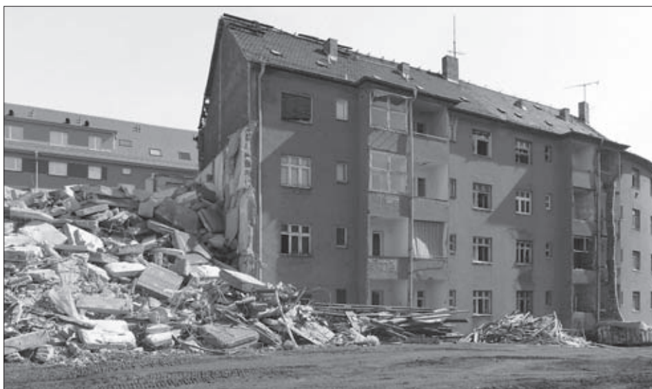
Blick vom Innenhof auf die Wohnanlage Otto-Adam-Straße: Die Häuser 11 und 13 sind bereits abgerissen. An dieser Stelle entsteht der Neubau. Der Rest der Wohnanlage wird denkmalgerecht saniert. Quelle: VLW eG
