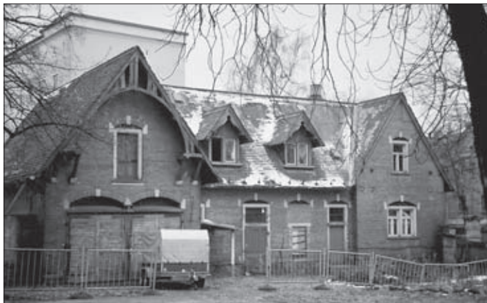
Das Seitengebäude der Mothesstraße 2 am 6. Januar 2006 (im Hintergrund oben links Fenster der Gräfestraße 32)
