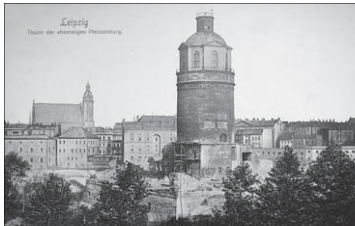
Die Pleißenburg während des Abbruchs, im Hintergrund die Thomaskirche
