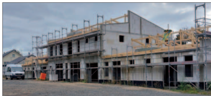
Der Rohbau an der Magnusstraße drei Tage nach dem Richtfest
