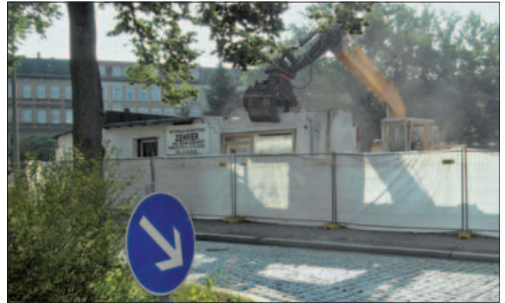
Abriss der Gebäude von Motorrad-Verwertung Zehrer, 2014
