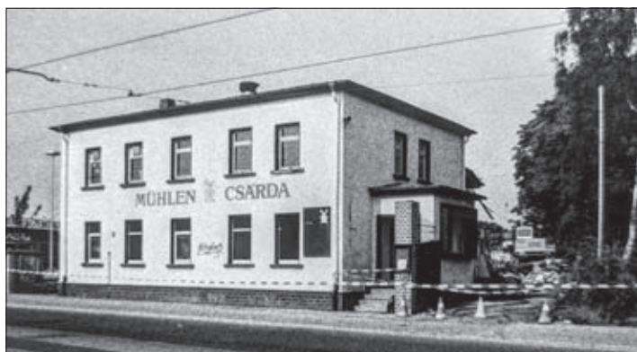
Die „Mühlen Csárda“ beim Abbruch, Juni 1992
