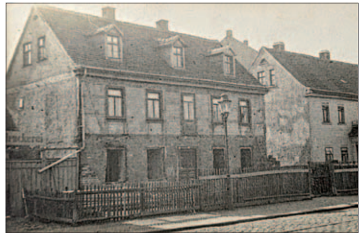
Die Delitzscher Straße 58, Umbau, um 1929
