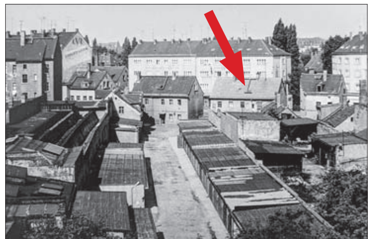
Die Hofansichten der frühen Häuser der Eutritzscher Ortserweiterung, von links: Delitzscher Straße 54, 56, 58 (Pfeil) und 60 (um 1960, Archiv Grundmann)
