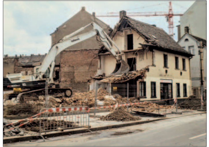
Abbruch der Delitzscher Straße 56 (ehemals Möbeltransport Naumann), am 24. Januar 1995 (Archiv Grundmann)
