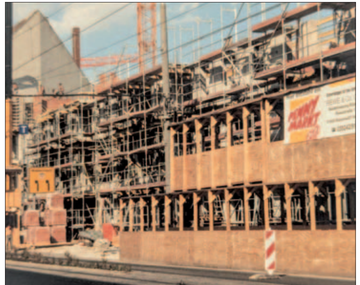
Das „Eutritzscher Zentrum“ mit „Pfeiffer's Hof“ im Bau, am 22. Juli 1996
