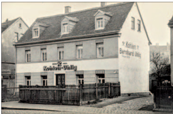
Die Delitzscher Straße 58, nach dem Umbau, um 1931
