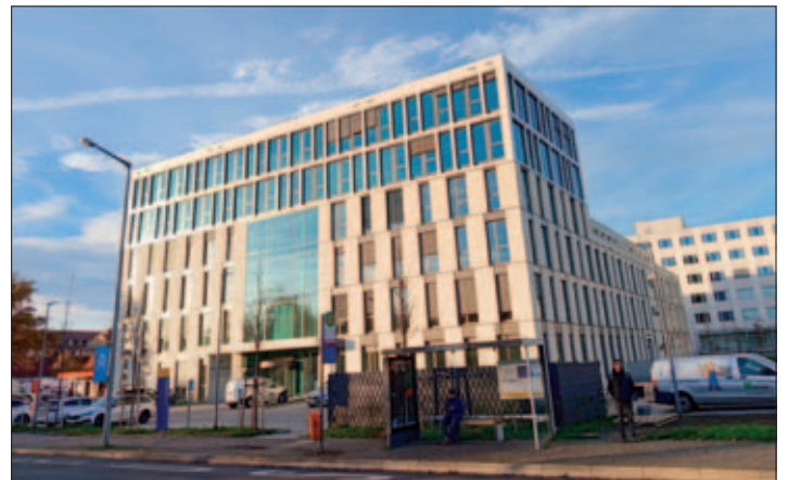
Das neue Bürogebäude an der Theresienstraße/Ecke Maximilianallee, am 5. November 2025
